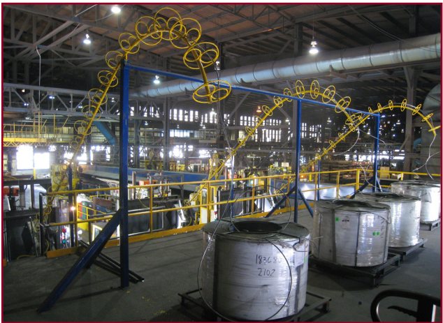
图2：多台喂线机用于原铁水预处理和校正处理。
